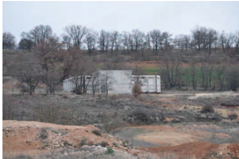
Nuevo depósito regulador de la urbanización.
