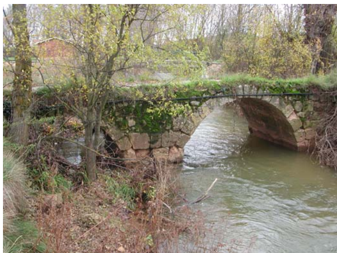
Puente sobre el río de los Ausines, vista aguas arriba
