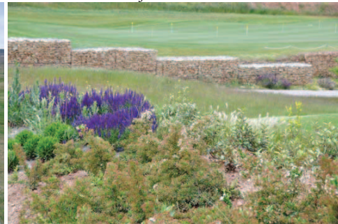
Vallado con gaviones en zonas con desnivel.
