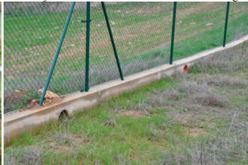
Gateras en zócalo de vallado metálico.
