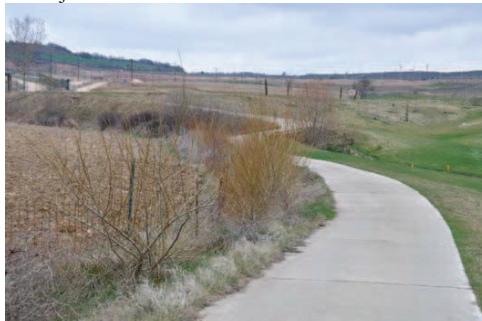
Vallado perimetral con matorral.
